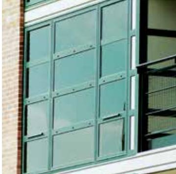
Renson® a développé toute une gamme d'entrées d'air. Dans un souci de qualité et de durabilité, Renson® a choisi de réaliser ces entrées d'air en aluminium. Les entrées d'air s'intègrent parfaitement sur un châssis en bois, PVC ou aluminium que ce soit dans le cadre d'une rénovation ou d'une construction nouvelle.
